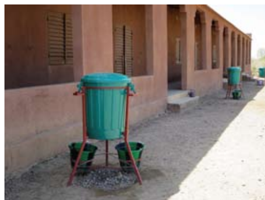
カラが建設したカチョラ小学校に設置したエボラ予防手洗い用具
