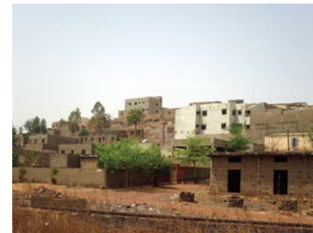
建設中の住宅
