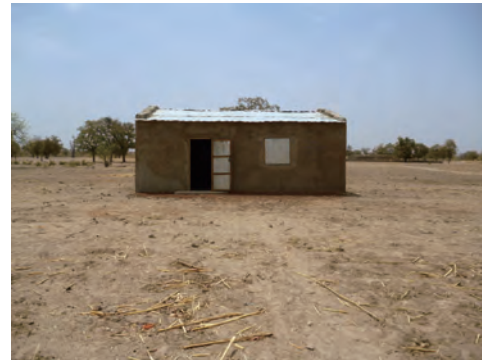
ソニブレ村に新設された識字教室。 村人たちによる建設です
